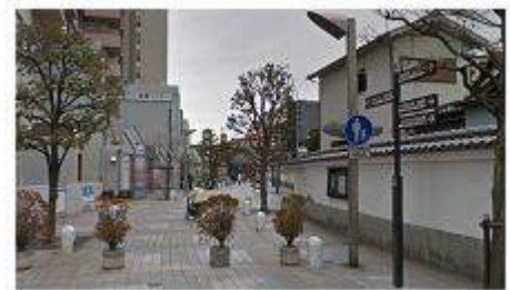
< 無電柱化された(都)中央伊丹線 >
