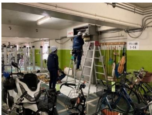
【船原自転車駐車場 シャッター更新工事】
