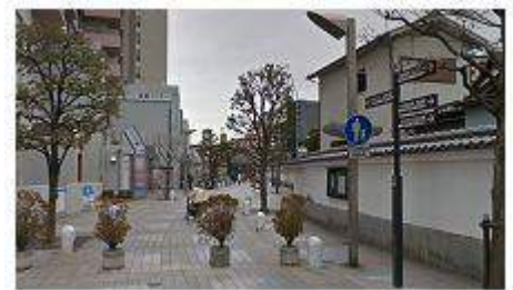
< 無電柱化された(都)中央伊丹線 >
