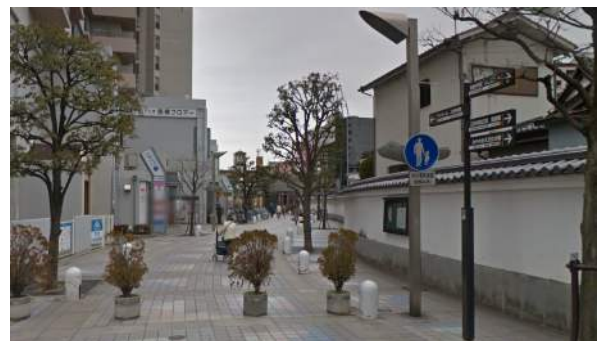
< 無電柱化された(都)中央伊丹線 >
