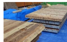
建物に使用したCLT材
