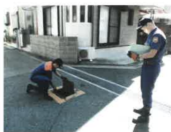
【消火栓の点検】
