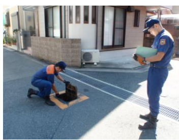
【消火栓の点検】
