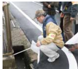
排水溝の幅を確認
