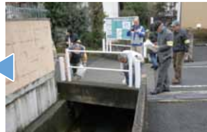
水路の状況や幅を確認
