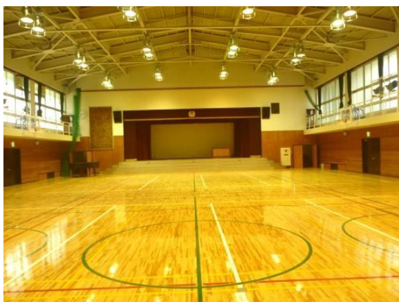
大規模改造と非構造部材の耐震化された体育館 (稲野小学校)
