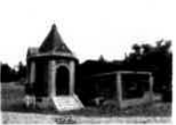
第47号 潮見台浄水場管理棟
