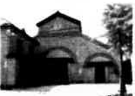
第66号 旧広海倉庫
