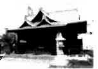
第50号 水天宮本殿、拝殿
