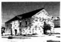
第53号 旧日本石油櫓倉庫
