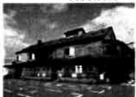
第64号 旧岡崎倉庫
