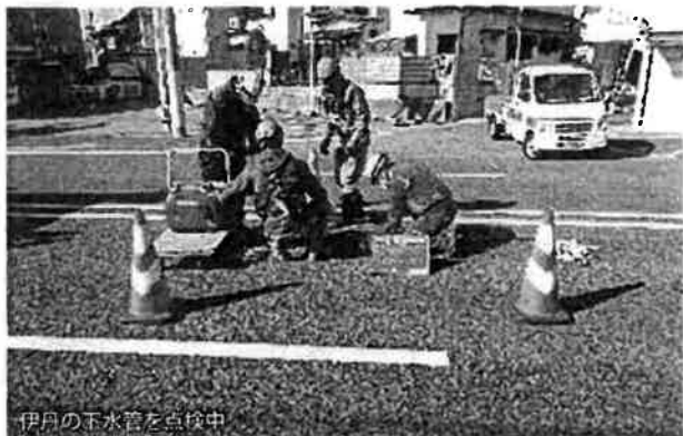
伊丹の下水管を点検中
