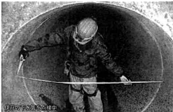
伊丹の下水管を点検中
