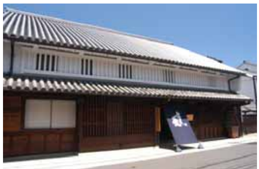
【国指定重要文化財 旧岡田家住宅】
