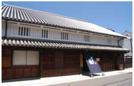
【国指定重要文化財 旧岡田家住宅】
