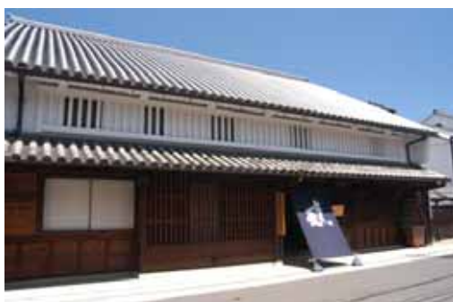
【国指定重要文化財 旧岡田家住宅】
