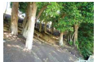
急傾斜地で法面対策工事が行われた箇所には地域性外来植物の植栽を予定。
