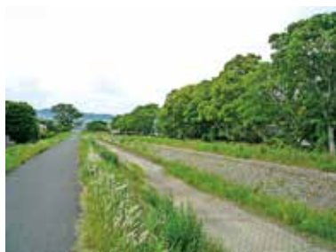
天神川：長尾山から南流。国道 176 号付近から南は天井川。昆陽池で西進し天王寺川に合流する。武庫川に注ぐ。
