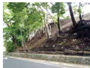
伊丹緑地：災害時の被害軽減のため、急傾斜地において法面保護対策を実施している。
