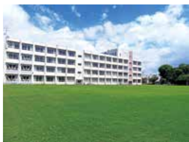
神津小学校：コミュニティ・スクールの一環として、市内の小学校で初めてグラウンドの全面を芝生化している。
