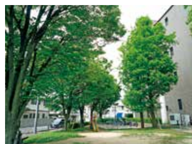
ラストホール：接道部にケヤキ等の緑地を配置し、街角の修景緑化を図るとともに子どもの広場を提供している。
