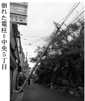
倒れた電柱(中央5丁目)
