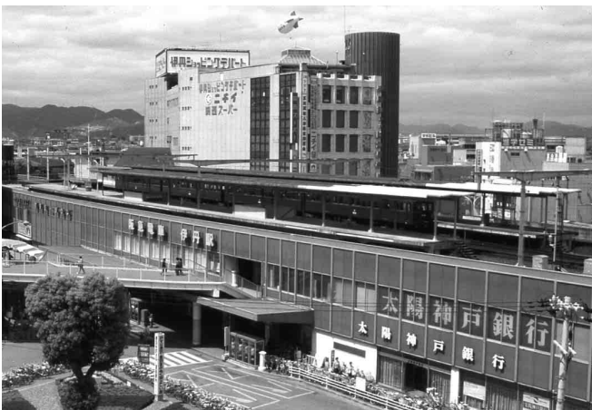
旧阪急伊丹駅。ホームは2面3線構造だった(阪急電鉄提供)
