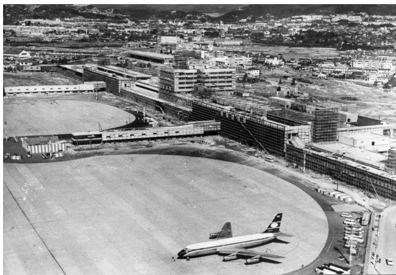
完成を目指して工事中の大阪国際空港ターミナル（昭和43年12月4日）
