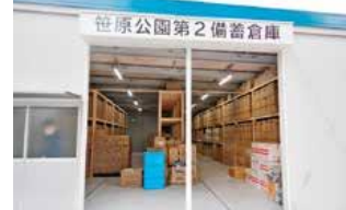
笹原公園内の第2備蓄倉庫
