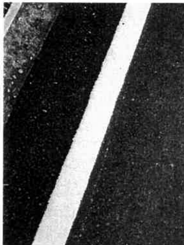
引き直された車道外側線
