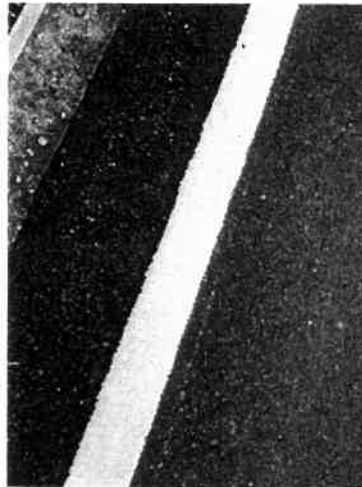
引き直された車道外側線
