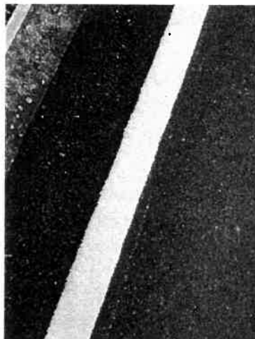
引き直された車道外側線
