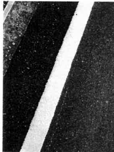
引き直された車道外側線
