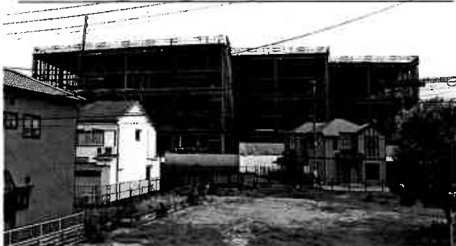
西桑津に建設中の物流倉庫（高さ23M）
