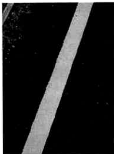
引き直された車道外側線
