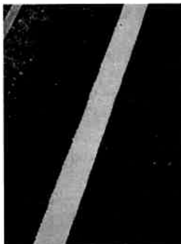
引き直された車道外側線
