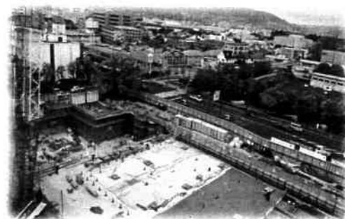
令和4年11月の竣工を目指し、工事が進む新庁舎
