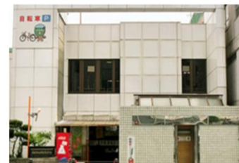
駐輪場/トイレ全景
