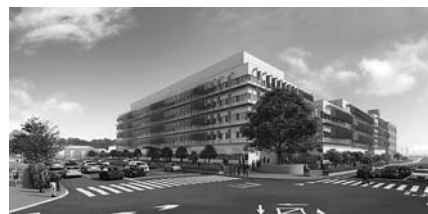
免震構造の市役所新庁舎(イメージ)
