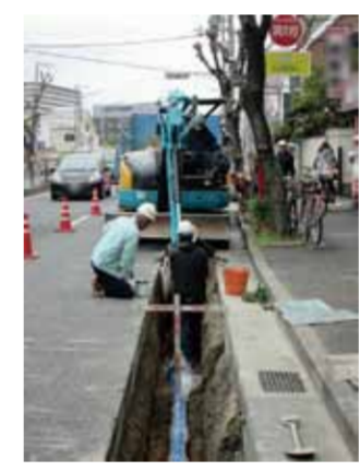
耐震管への更新工事の様子
