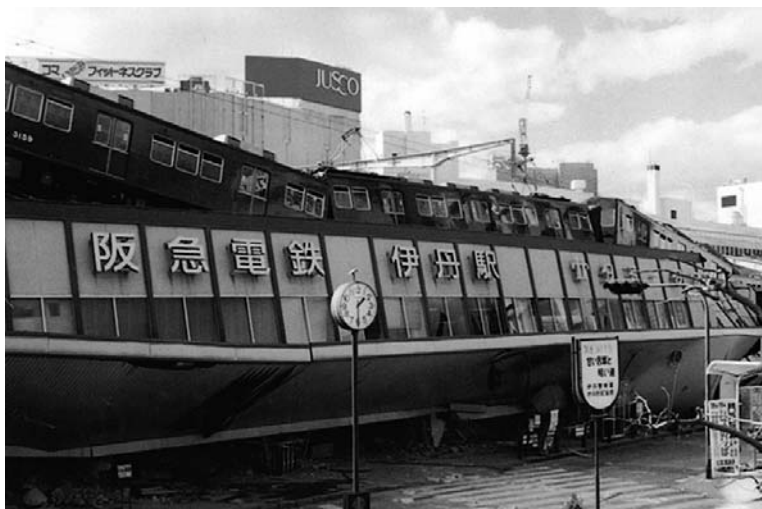
阪神・淡路大震災で被災した阪急伊丹駅
