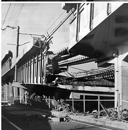
倒壊した高架
