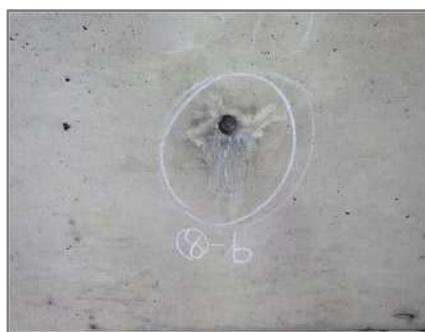
材料劣化による剥離や漏水・遊離石灰が見られます
