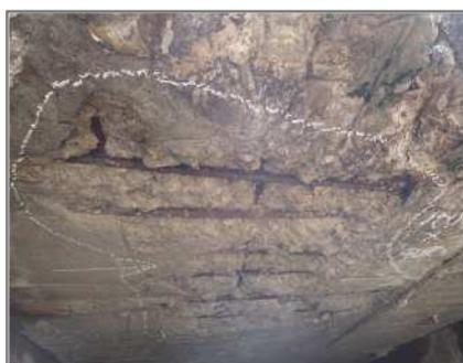
RC主桁に剥離・鉄筋露出が見られます
