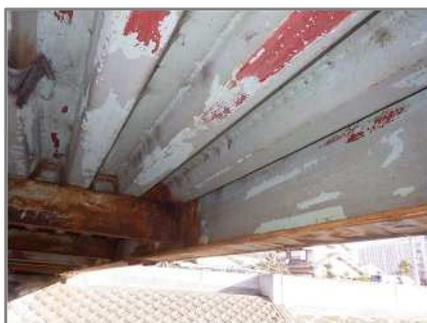
鋼橋の主桁に腐食が見られます
