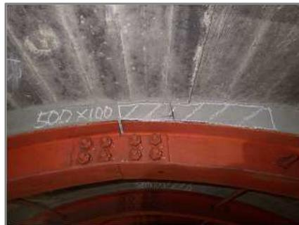
材料劣化によるひびわれ、うきが見られます
