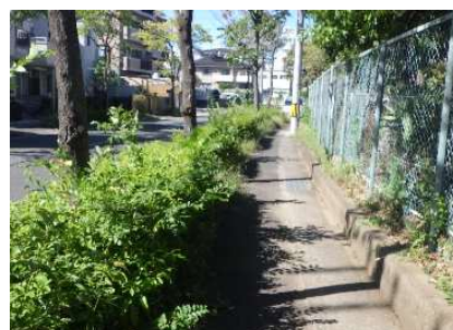
図 2-2 連続植栽柵箇所における、 有効幅員狭小箇所(池尻 2050 号線)
