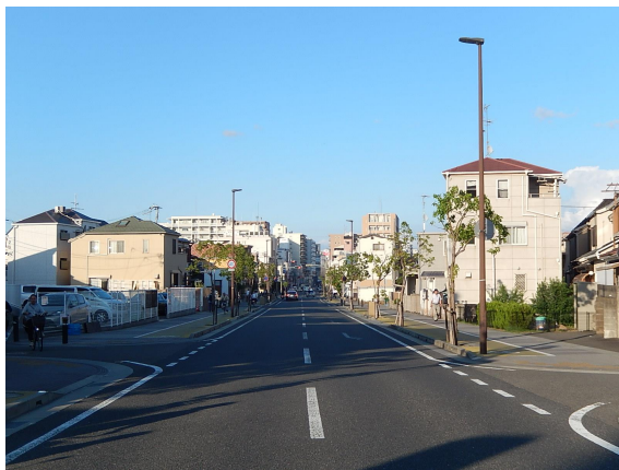
図 2.1 無電柱化整備状況 (都市計画道路山田伊丹線 行基町)
