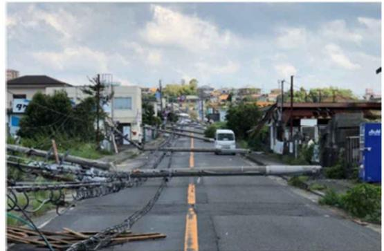
図 4.1 倒壊した電柱による道路閉塞
