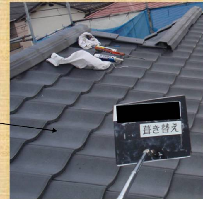
耐震改修工事完了の状況 工事順番④
