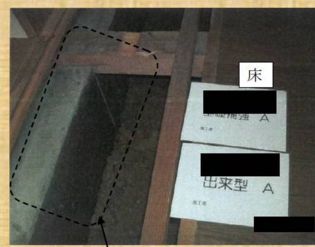
耐震改修工事中の状況 工事順番⑤
