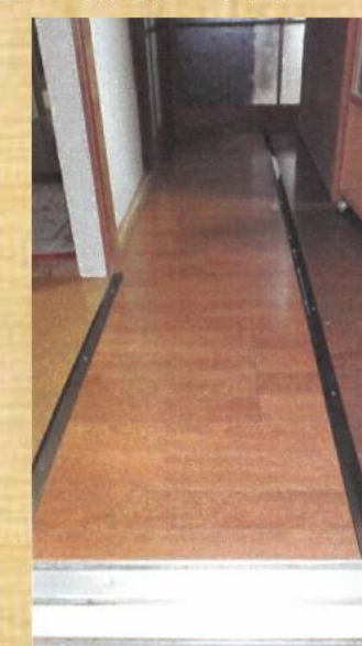
耐震改修工事完了の状況 工事順番⑥
