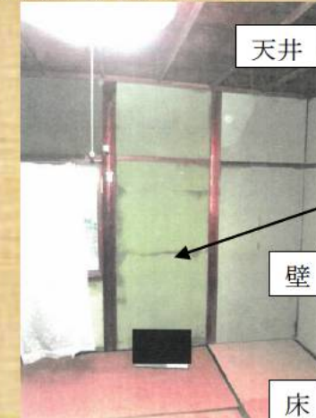
耐震改修工完了の状況
