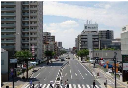
尼崎池田線の道路空間。沿道建築物と道路空間は連続して配置されている。
