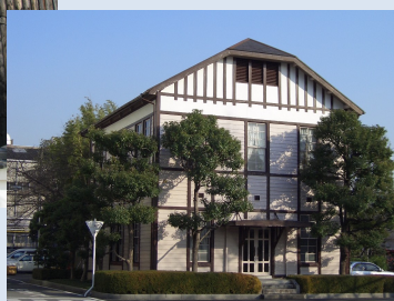
指定第2号 東リ旧本館事務所
