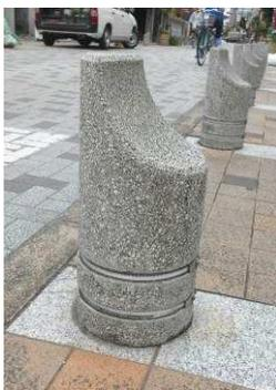
擬石材を用いた駐車止めを使用している。
