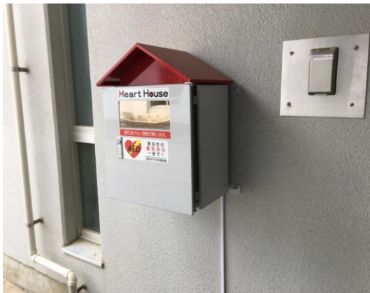
(伊丹小学校 廊下外壁)
