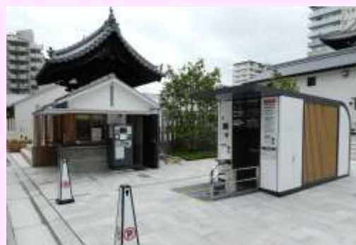
伊丹機械式自転車駐車場
