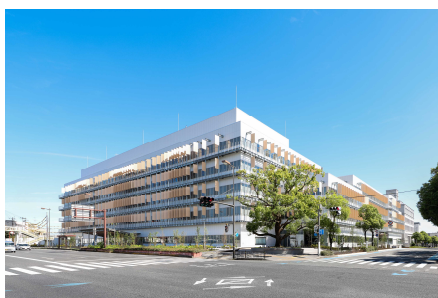
▲外観写真(北西から撮影)
