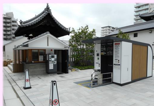
伊丹機械式自転車駐車場
