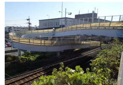
有岡大橋歩道橋
