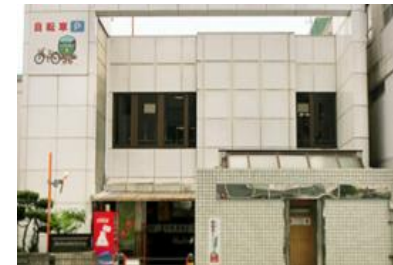
駐輪場/トイレ全景
