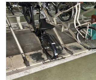
自転車ラック現況
