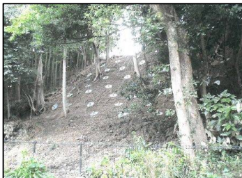
②対策後 (平成25年度撮影)
