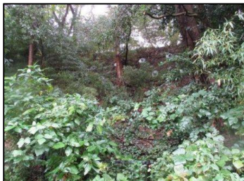
③対策後(5年経過) (平成30年度撮影)
