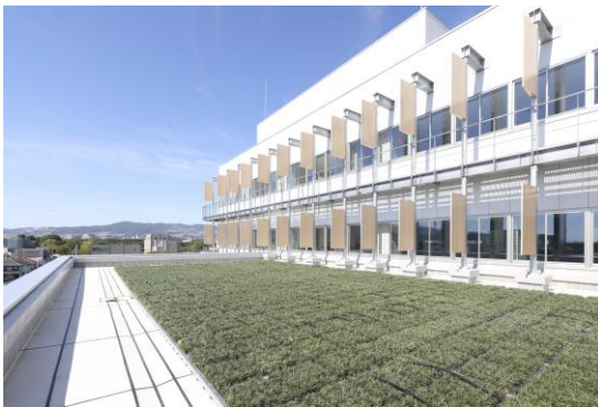
(完成写真：4階屋上緑化)
