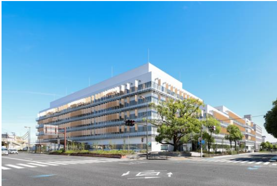
(完成写真：国道 171 号より)
