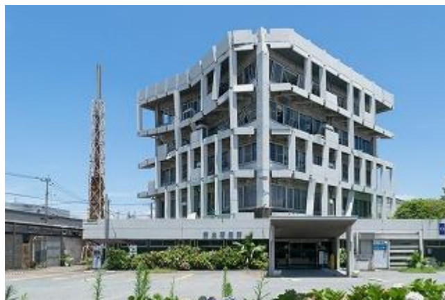
被災した宇土市役所
