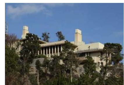
「旧山邑家住宅（淀川製鋼迎賓館）」
