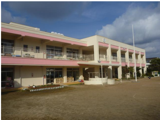
耐震・大規模改造によりリニューアルされた園舎 (天神川幼稚園)
