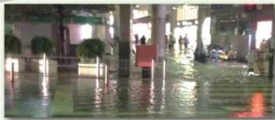
【阪急伊丹駅前広場冠水の様子】
