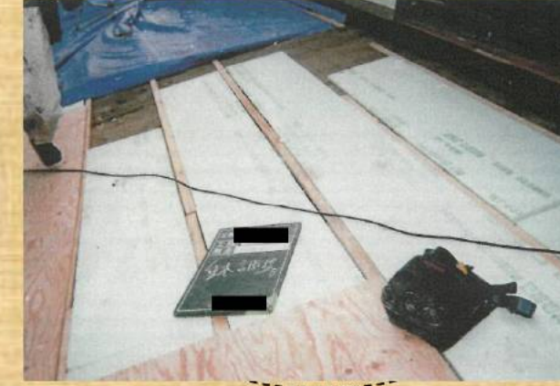
耐震改修工事中の状況
