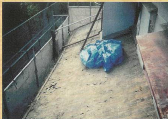
耐震改修工事中の状況
