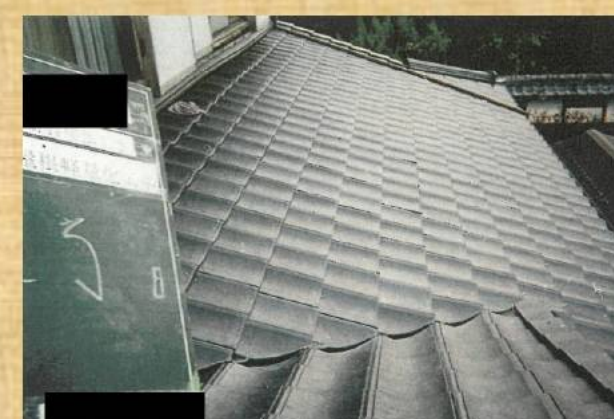
耐震改修工完了の状況
