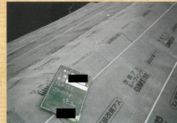
耐震改修工事中の状況
