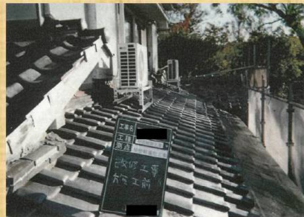
耐震改修工事前の状況
