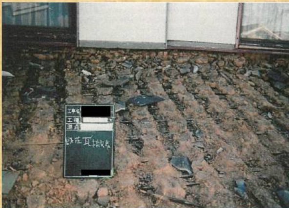
耐震改修工事中の状況
